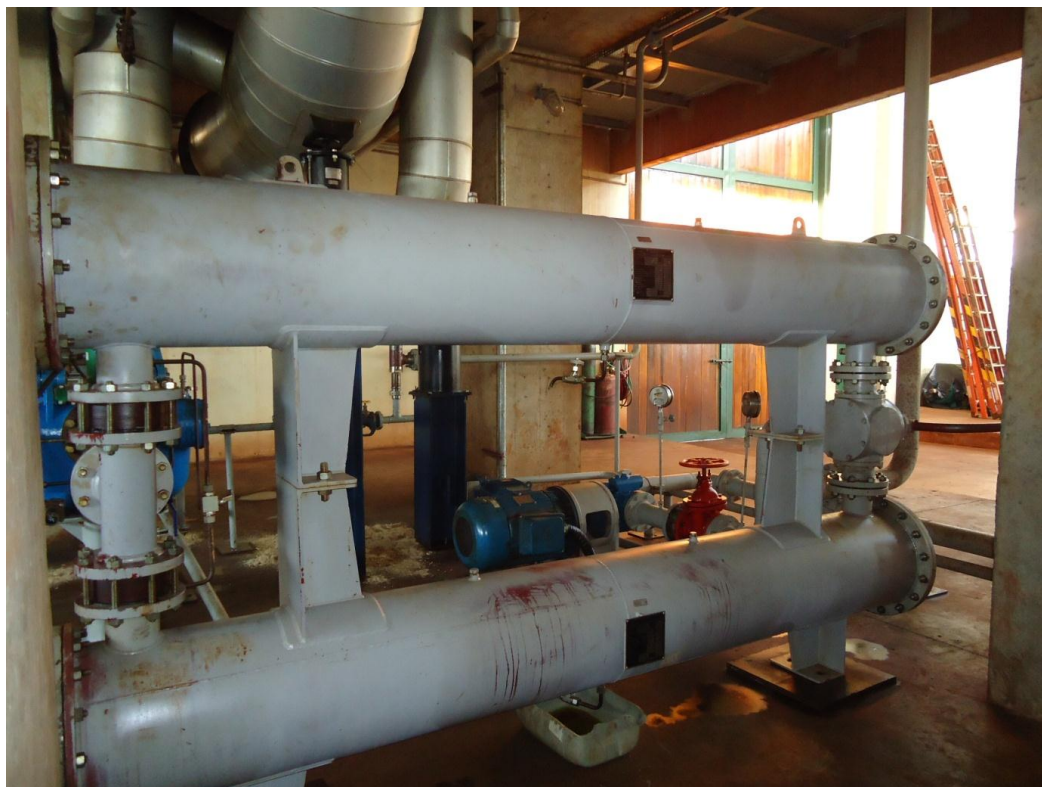
FIGURA 08: Trocador de calor tipo casco e tubos da Usina Floresta S.A.
